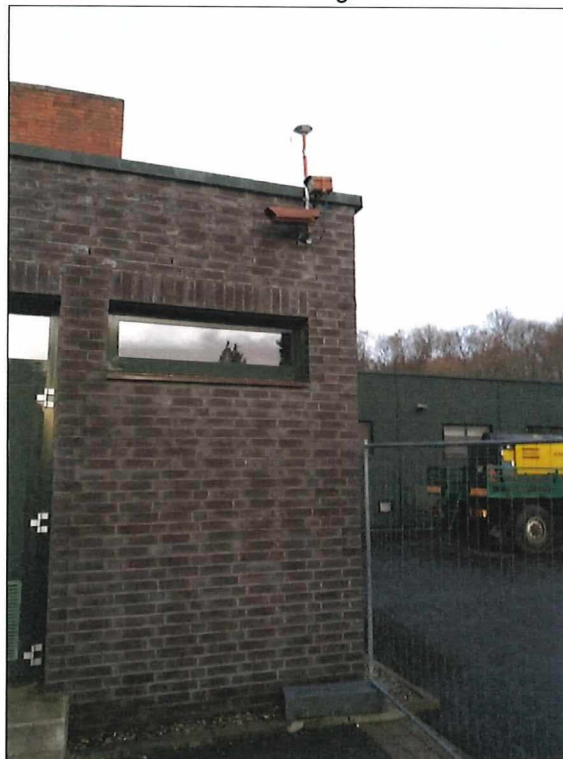
Abbildung 9: Der als GPS-RTK-Referenzstation verwendete Punkt ist an der Wand des Bürogebäudes befestigt.
